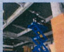
工場設備点検
