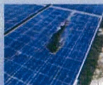
太陽光パネル点検
